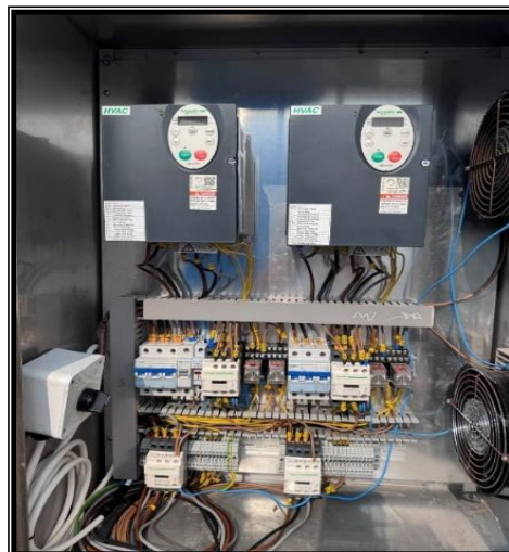
新安装的变频式机组控制表板
