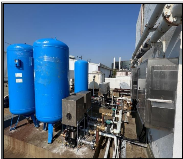
新安装的食水及冲厕水抽水机组采用变频式技术，以期优化能源效益
