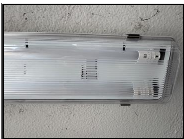
装有新更换发光二极管光管的灯具
