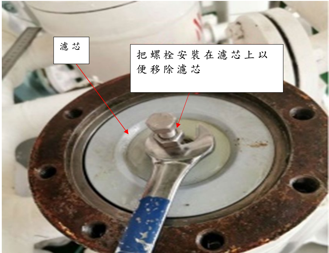
圖3：移除墊圈後的濾芯俯視圖
