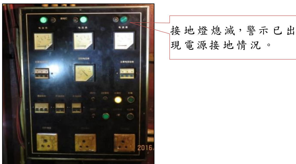
圖6：機艙電箱接地燈熄滅，警示該電源已出現電源接地，即漏電情況。
