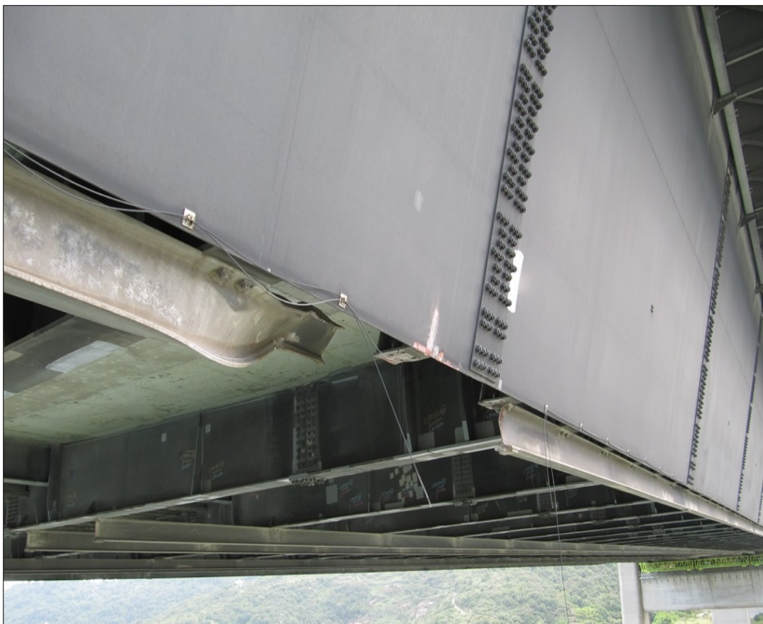
圖 5 -橋底金屬結構多處損壞（橋底檢查維修路軌斷裂）
