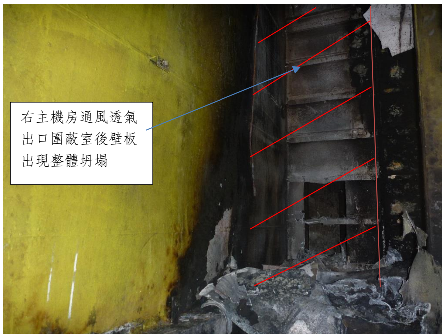
圖 4. 右主機房通風透氣出口圍蔽室後壁板出現整體坍塌
