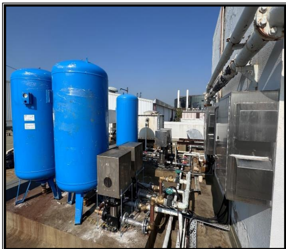
新安裝的食水及沖廁水抽水機組採用變頻式技術，以期優化能源效益
