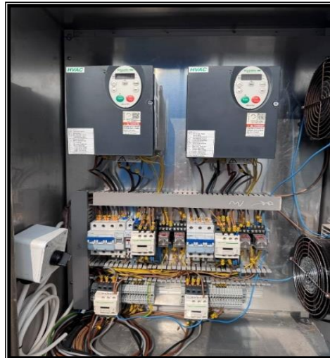
新安裝的變頻式機組控制錶板
