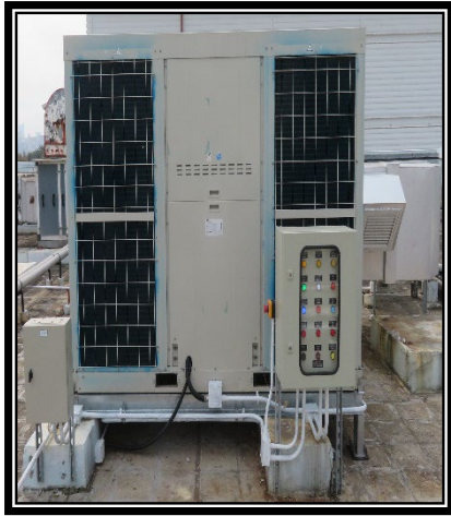
天台的暖氣、通風及空調裝置
