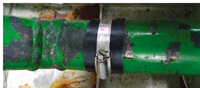
喉箍或紮帶加上橡膠墊片解決小規模喉管洩漏
