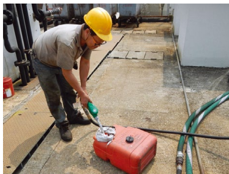
用吸油棉圍繞入油口，吸收濺出的油霧
