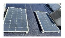
如太陽能電力系統發生火警,不應直接用水來撲滅,以免觸電。倘 火勢初起,在安全情况下,應首先關閉供電總型,切斷電力供應, 並可使用乾粉或二氧化碳滅火筒撲滅。(註1及2)
